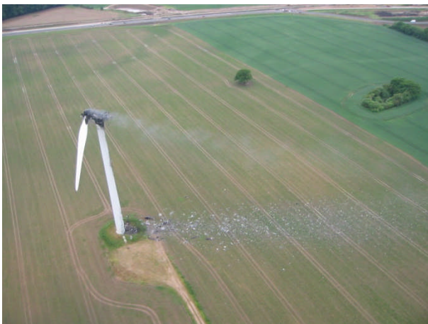
Deutlich zu sehen ist der Trümmerschatten der brennenden Anlage.
